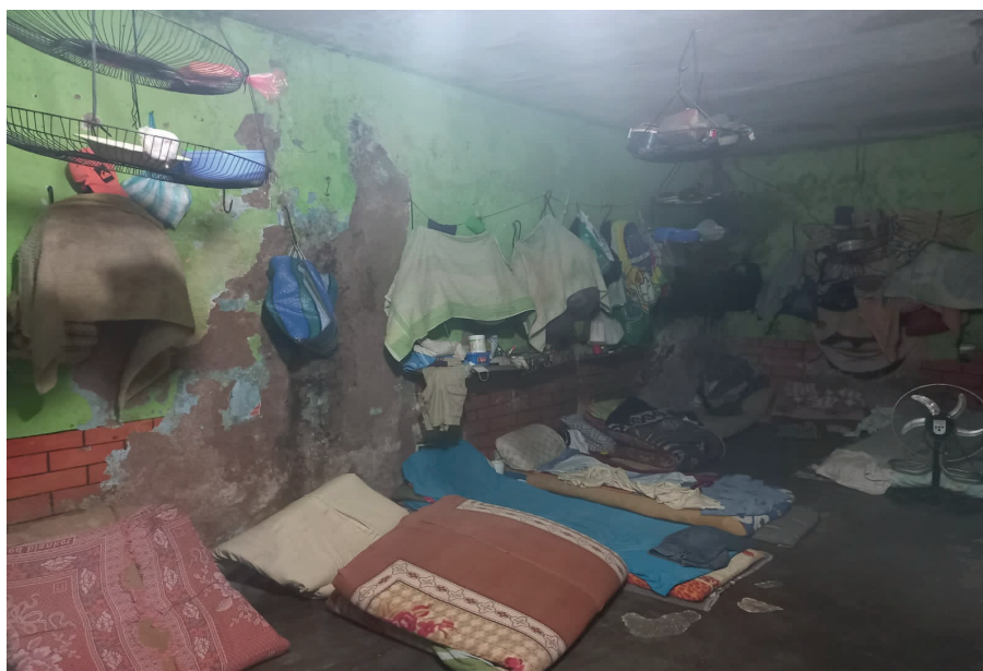
Dormitorio en malas condiciones de salubridad en el centro penitenciario de Bahía, municipio Puerto Suarez, departamento Santa Cruz.
